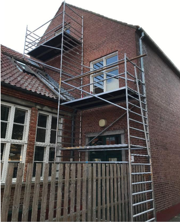
Der skiftes et par vinduer i E-bygningen.
